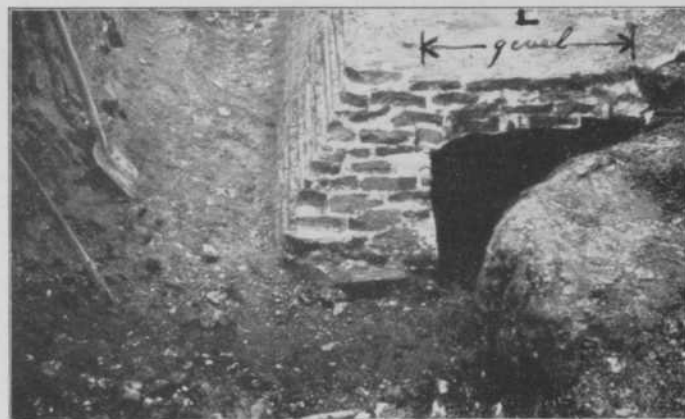
Fundeering van den koorveelhoek met aanduiding van den opgaanden gevel, die naast de fundeering stond.
